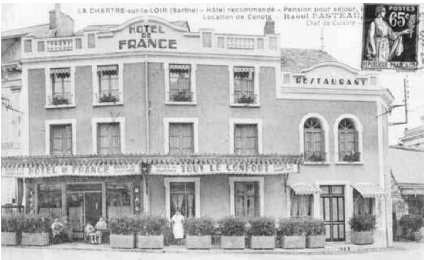
Raoul Pasteau in 1936-37. The front is changed to the form we recognise today, constructed in the style of Art Deco, the Annexe is converted from the Butcher's Shop to provide extra accommodation. / Raoul Pasteau - en 1936-37- la façade devient celle que nous connaissons aujourd'hui dans le style Art Déco. La boucherie devenue annexe devient un logement supplémentaire.
